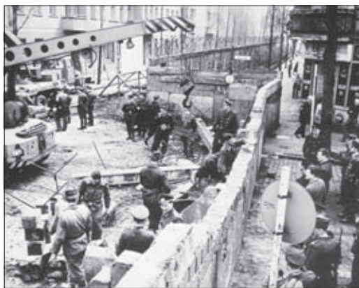
A berlini fal építése...
